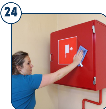
Reinig de brandkast en de aansluitingen volledig.
